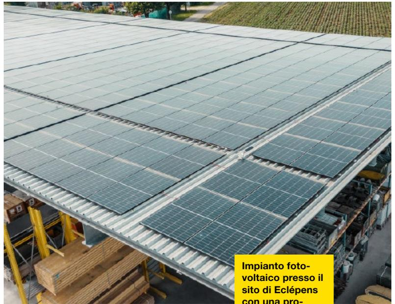
**Impianto foto-voltaico presso il sito di Eclépens con una pro-duzione annua di 290 MWh**
