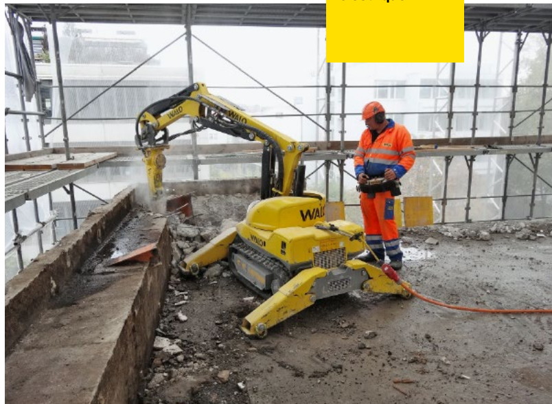
Robot de démolition à motorisation électrique
