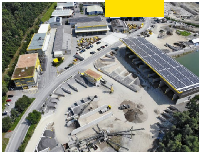
Installation de recyclage de gravier et de ballast sur le site de Goldach
