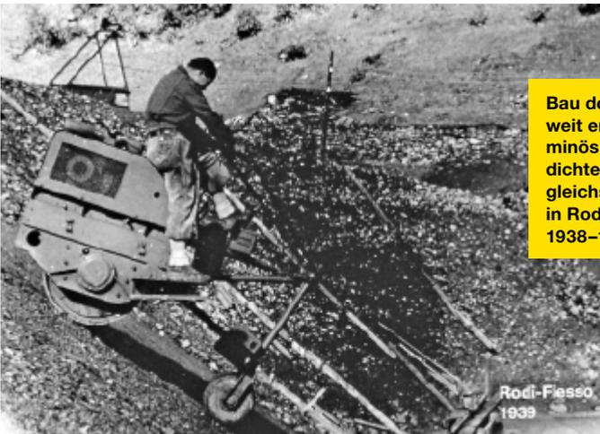
**Bau des weltweit ersten bituminös abgedichteten Ausgleichsbeckens in Rodi-Fiesso, 1938–1939**
