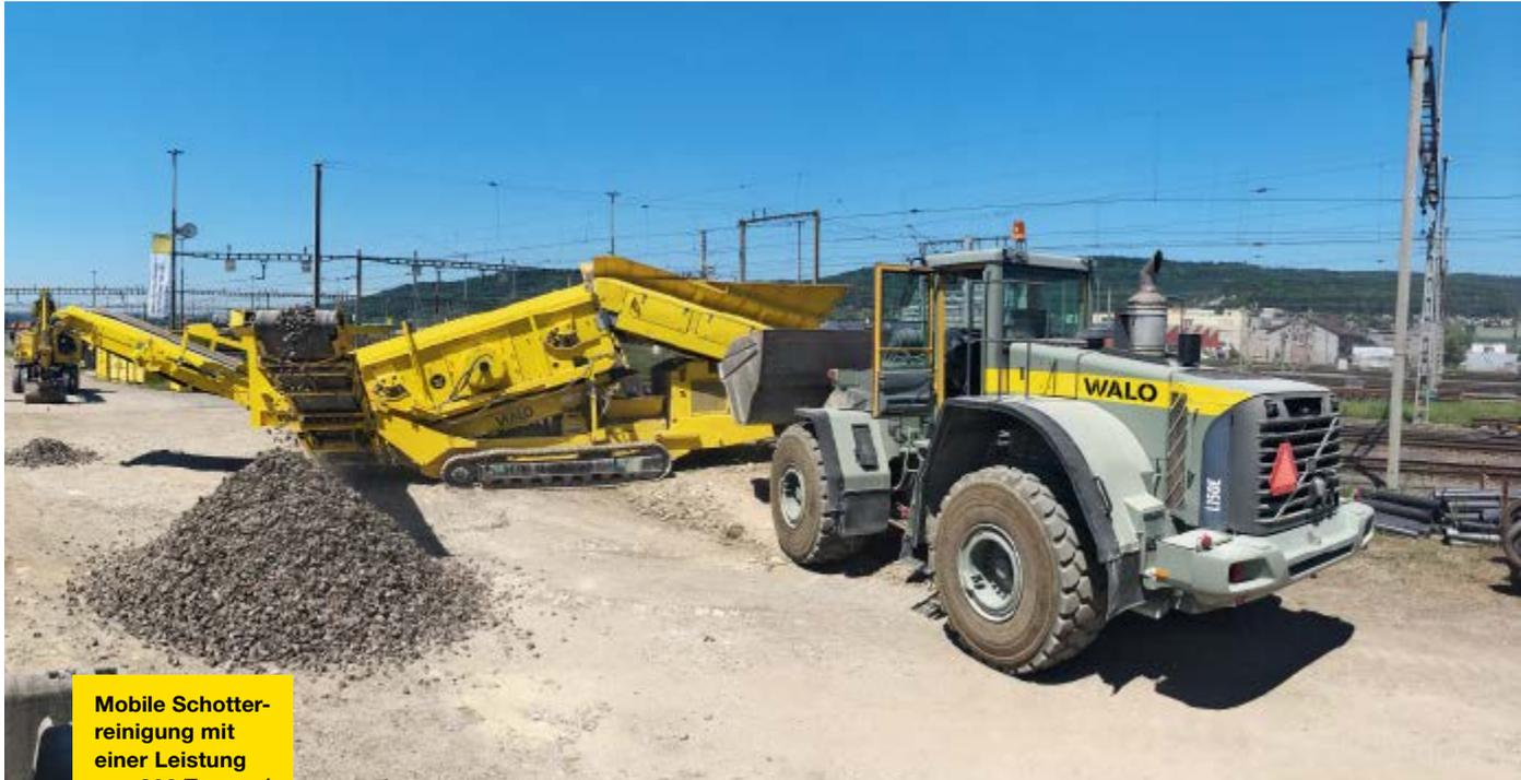
**Mobile Schotterreinigung mit einer Leistung von 300 Tonnen/ Stunde**
